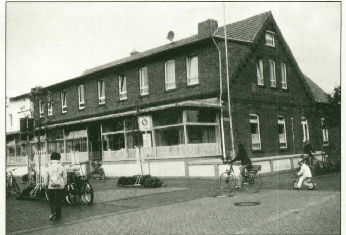
Abb.1: Das ehemalige Schullandheim Dresden vor dem Abbruch, 2008.
