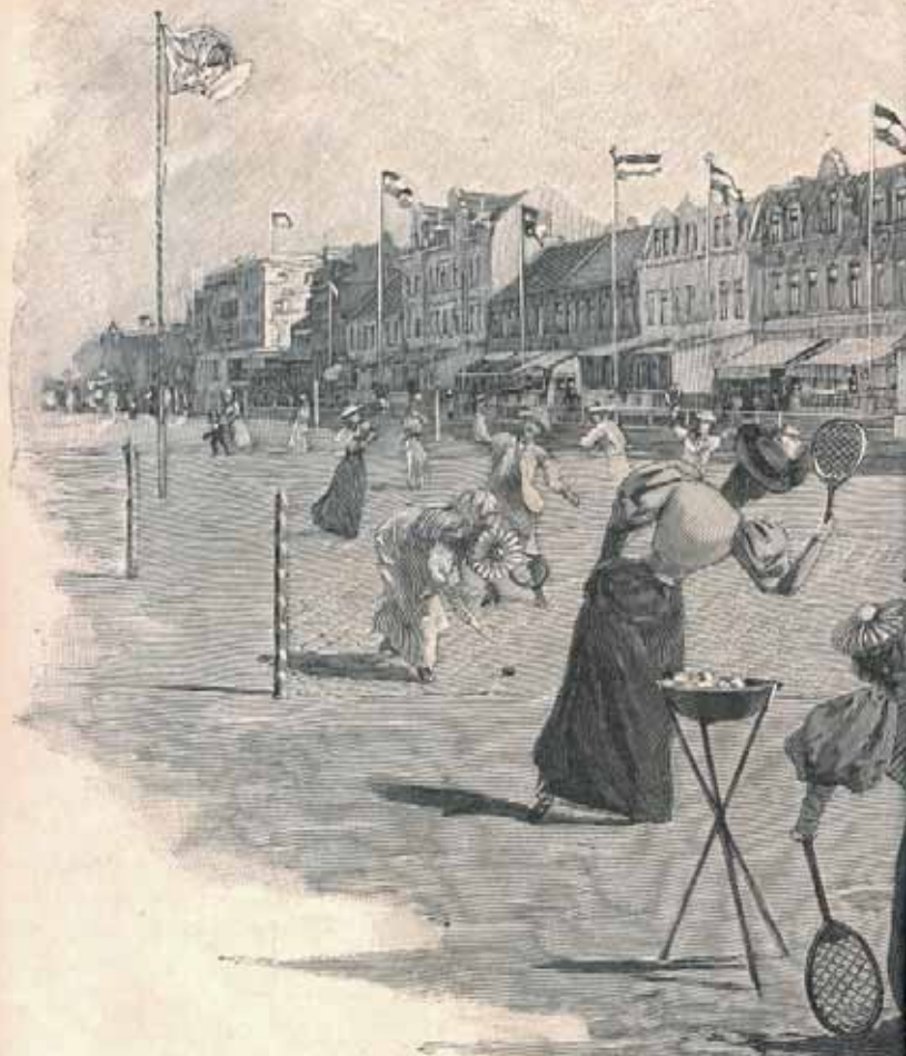
Norderney. Kaiserstrasse und Leschalle.
