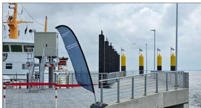
Niedersachsen Ports als Bauherr hat im Laufe der Baumaßnahme 2.600 Kubikmeter Sand, 250 Bohrungen mit einer Länge von 2 Kilometern, 585 Tonnen Baustahl und 280 Kubikmeter Beton verbaut und rund 8 Millionen Euro investiert.
