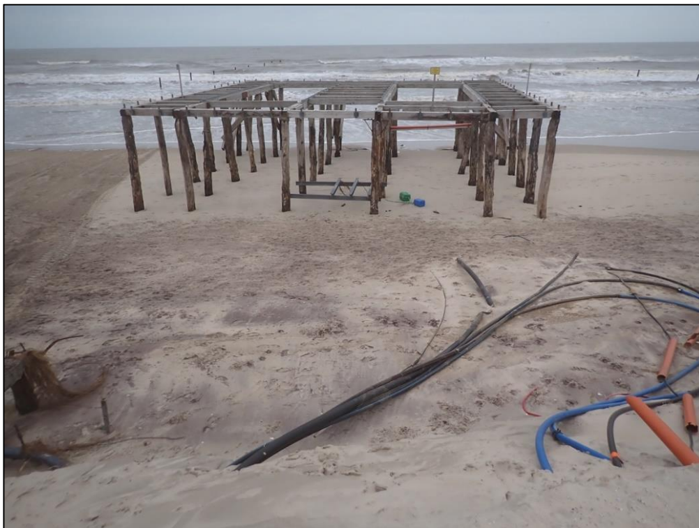
Abbildung 4: Unterkonstruktion der Außengastronomie
