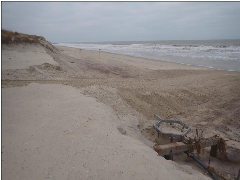
Abbildung 6: Aufgeschüttete Rampe als Zugang zum Strand (OVW/DOS)
